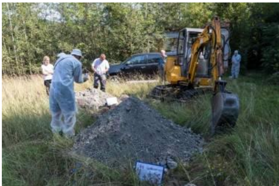
Slika 3. Razdvajanje materijala u dve gomile prilikom eskavacije na prvom jalovištu.
