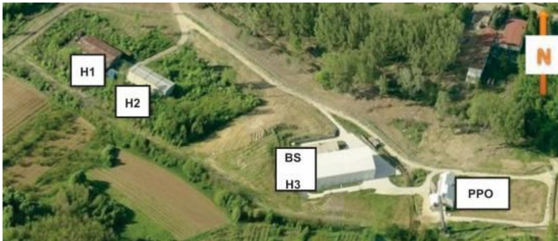
Slika 1. Lokacija objekta PPO u ograđenom kompleksu za upravljanje RAO (Hangar H1; Hangar H2; Objekat za bezbedno skladištenje jakih izvora zračenja - BS; Objekat za skladištenje čvrstog radiaktivnog otpada - hangar H3; PPO - Postrojenje za preradu otpada.
