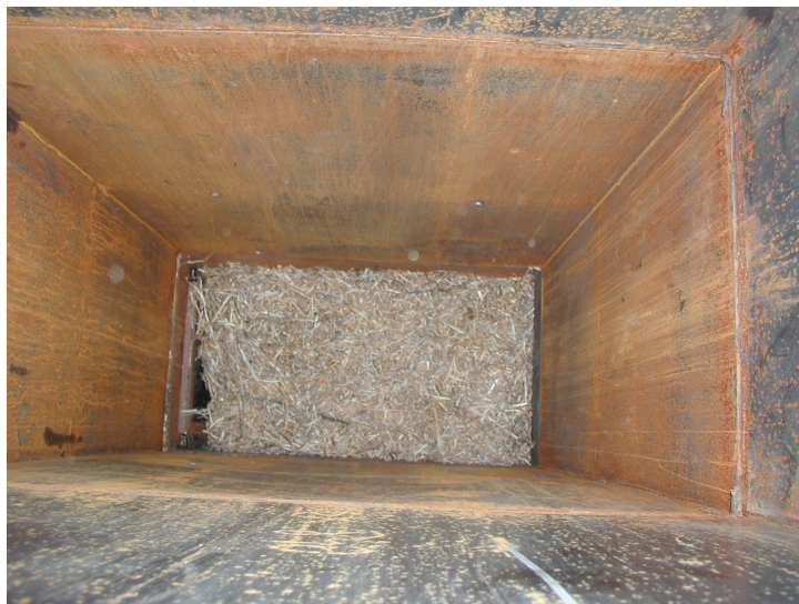
Slika 3. Pogled na unutrašnjost spremišta bala
