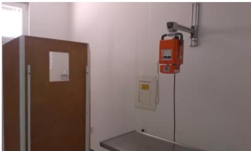
Slika 1. Prikaz postavke rendgen uređaja ORANGE 1060HF
