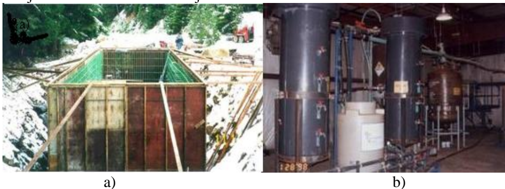
Slika 1. a) Izrada permeabilne reaktivne barijere [15] b) Postrojenje za dekontaminaciju zemljišta hemijskom ekstrakcijom [16]
